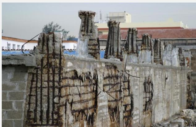
*Muros de contención del mar en La Habana, Cuba, destruidos por huracanes, y deterioro del concreto, 2007.*
